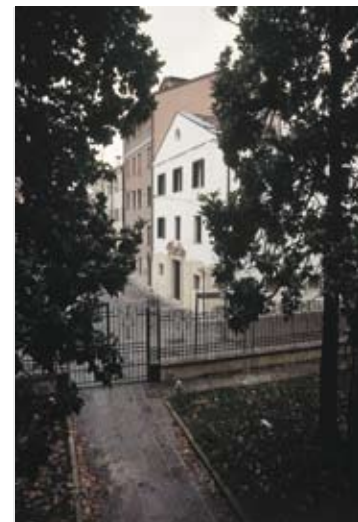
Fig.11 - L'edificio attuale sul luogo della chiesa di S. Girolamo
