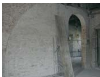
Fig.27 – Paramento murario interno durante l'intervento di recupero
