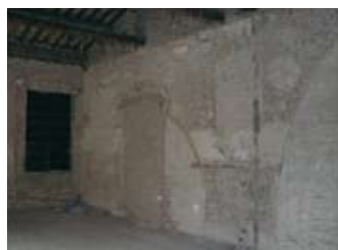
Fig.26 – Paramento murario interno durante l'intervento di recupero
