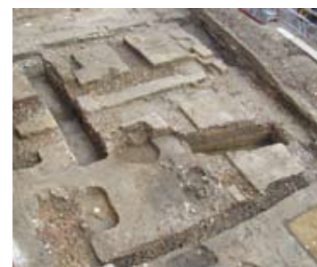
Fig. 17 - Fondazioni di muri in pezzame laterizio
